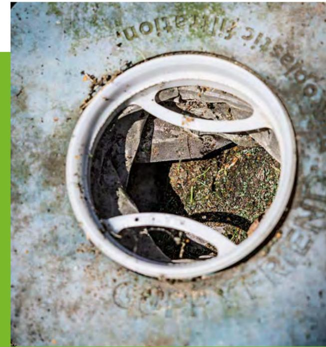
Die Filter verhindern, dass Mikroplastik ins Grundwasser gelangt.
